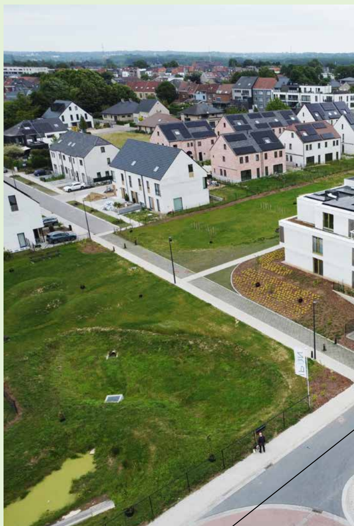
Voor de assistentiewoningen Zuunhof werden de nodige parkeerplaatsen ondergronds voorzien waardoor er meer (publieke) groenzone kon worden aangelegd.
