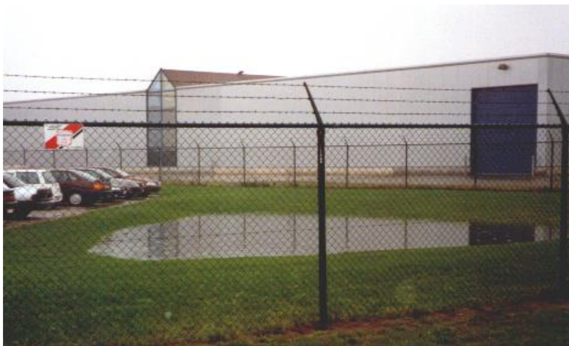
Bovengronds infiltratiebekken
