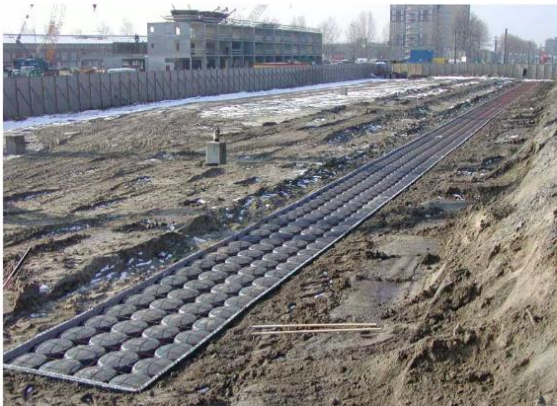
Aanleg van ondergrondse buffervoorziening – Waterblock BV
