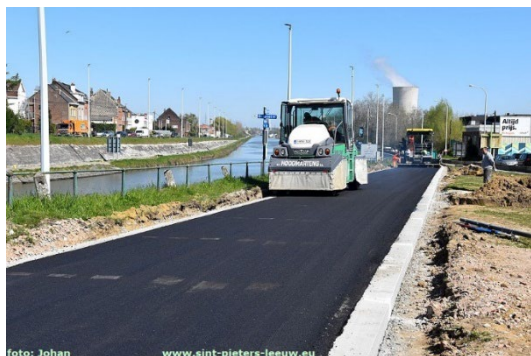
Aanleg fietssnelweg F20 kanaal Brussel-Charleroi
