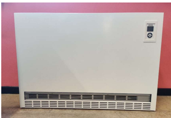
Geplaatste accumulatoren gemeentehuis.
