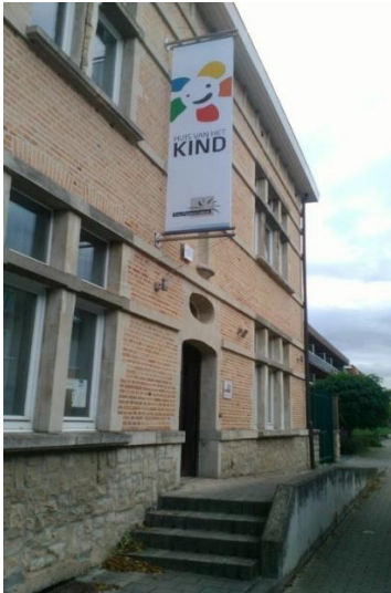
Gebouw huis van het kind
