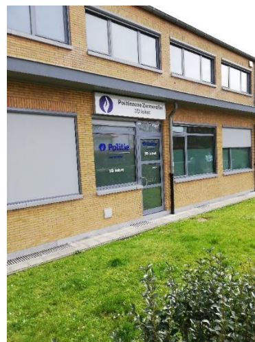
Gereinigde gevel en nieuwe lichtreclame
