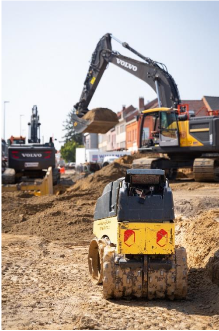
@Tineke De Vos Riolering- en wegenwerken Fabriekstraat fase 2.
