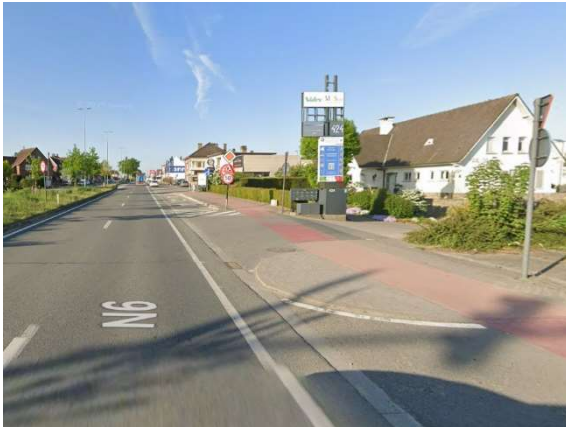
Foto 13: De Bergensesteenweg, net voorbij het lichtengeregeld kruispunt, ter hoogte van de inrit 'Bergensesteenweg 424' tot het huidige bedrijventerrein (met onder andere Agridistribution en Nidec), inrit wordt ook gebruikt door aanliggende villa.
