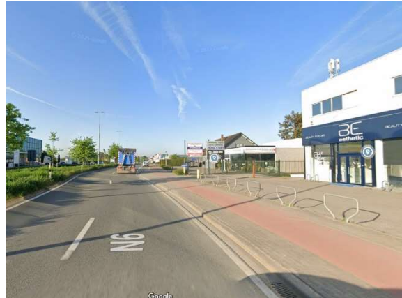
Foto 8: De Bergensesteenweg in het noorden van het plangebied met een KMO-verzamelgebouw en verder enkele kleine solitaire bedrijven. Ontsluiting en parkeren gebeurt rechtstreeks op de steenweg, gebundeld voor het verzamelgebouw.
