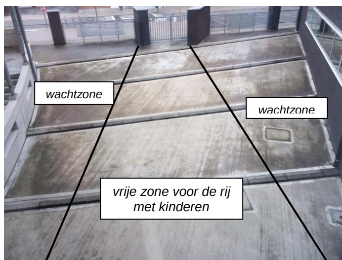
Bovenaanzicht toegang speelplaats lagere school
