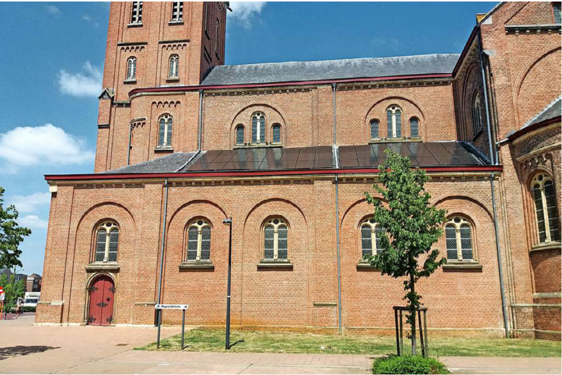
referentie: zonnepanelen op het dak van de Sint-Jan de Doperkerk in Paal (Beringen)
