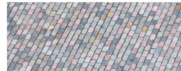
De vlakke kasseien voor de pleinverharding verwijzen naar de sfeer van de dorpen in het pajottenland, zijn waterdoorlatend en eenvoudig bewandelbaar. Door te werken met verschillende zachte kleuren wordt aansluiting gezocht met het kleurenpalet van het kerkinterieur.
