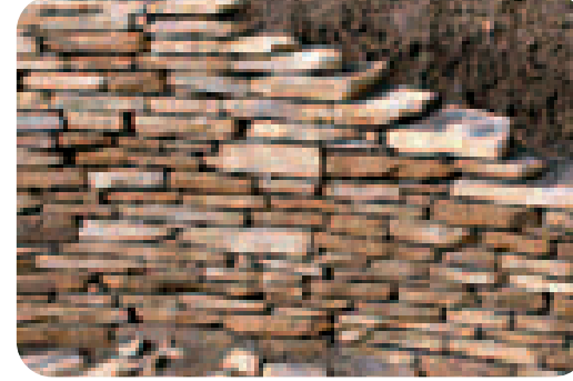
11 STAPELMUREN OVERSTORT BUFFERBEKKEN (materiaal : Grès du Bois)
